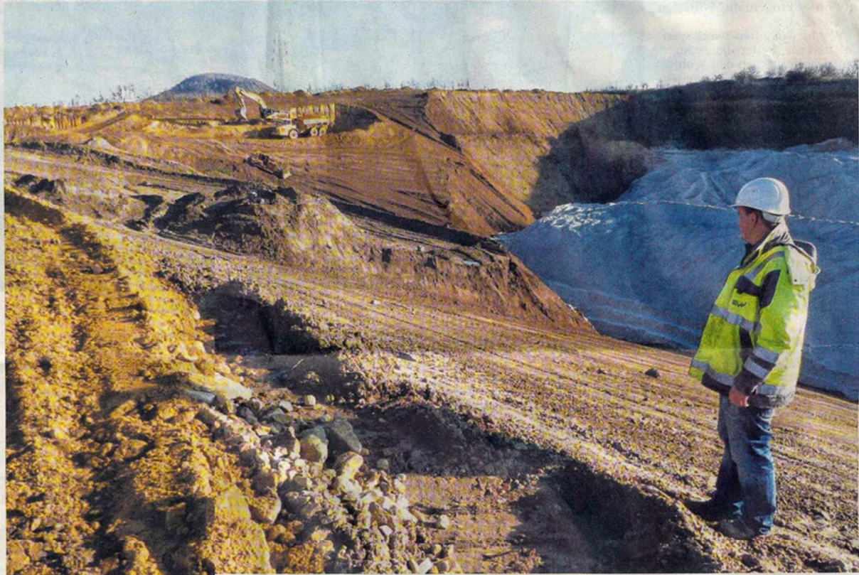
Noch wühlen sich Bagger und Planiermaschinen durch das Erdreich: Projektleiter Diplom-Ingenieur Matthias Betsch begutachtet den Fortschritt der Hangarbeiten im Tagebau Hochfeld, rechts im Hintergrund der feine weiße Quarzsand, der hier abgebaut wird. Fotos: Beatrix Opreée
