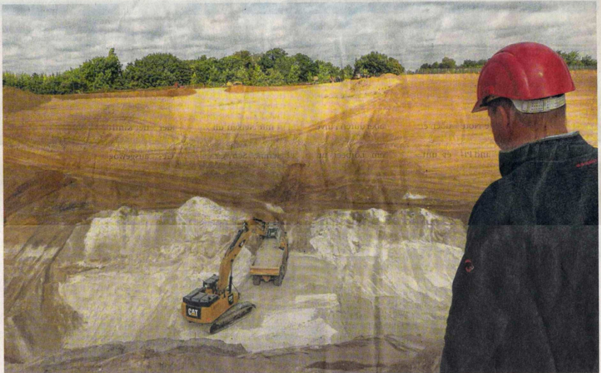
Der feine eisenarme Glassand wird noch abgebaggert und ins eigens angelegte Depot im Hochfeld gebracht: Ingenieur Dr. Matthias Betsch blickt auf den darüberliegenden Hang, auf dem in Kürze die Solarmodule für die Erweiterung des Solarparks installiert werden. Fotos: Beatrix Oprée
