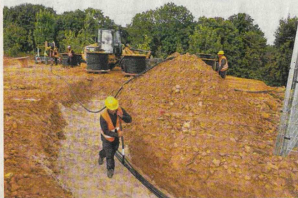
Muskelkraft ist gefragt: Die Mitarbeiter der Euskirchener Fachfirma ziehen die ersten Elektrokabel durch Gräben über das Gelände.
